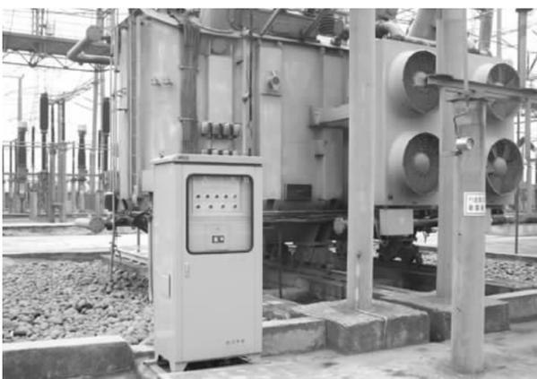
▲杭州柯林电力设备有限公司生产的变压器非电量智能监测控制系统
