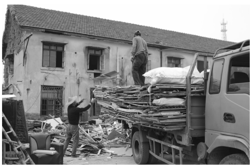
▲厂区内工人正在清理建筑垃圾
