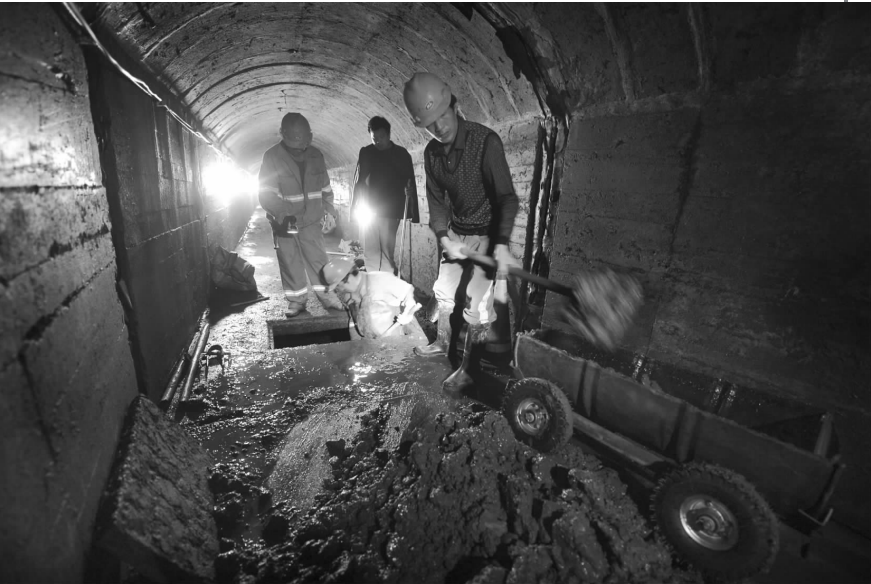
浣纱渠内的淤泥正在被施工人员一点一点清理出来
