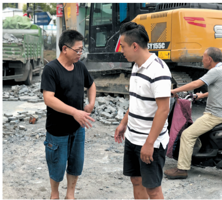
社区党委书记杨帆和物业主任查看施工现场
