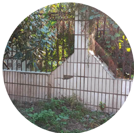
美政路6号北侧围墙破损
