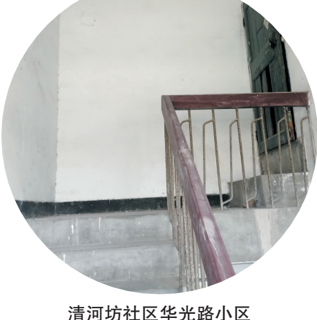
清河坊社区华光路小区 52 号楼道整改后
